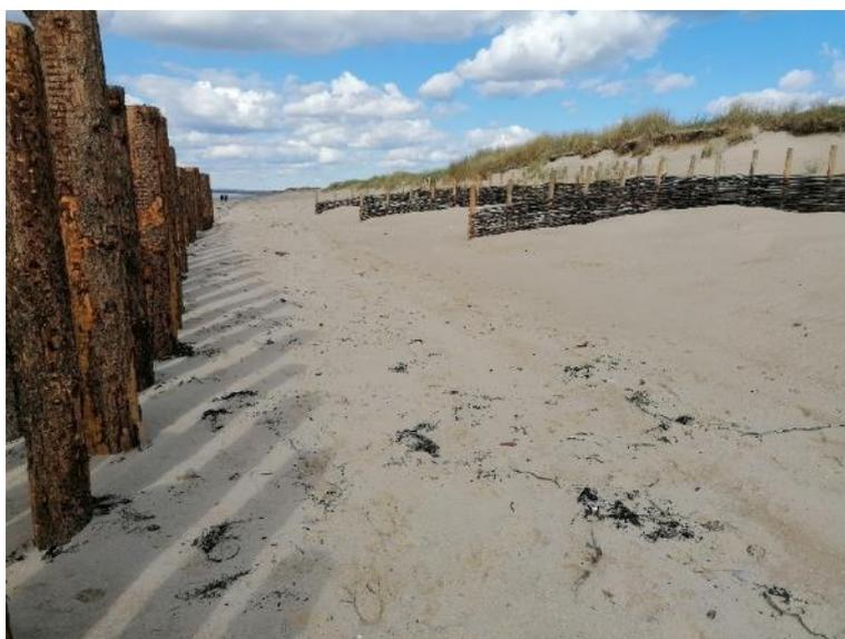
Figure 6 : Exemples d'aménagement de pieux hydrauliques et fascines
